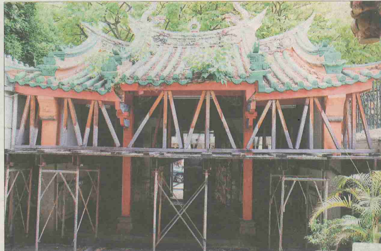
庆德楼的山门, 目前靠铁架和木条勉强支撑, 随时有坍塌危险。(庆德会提供)
